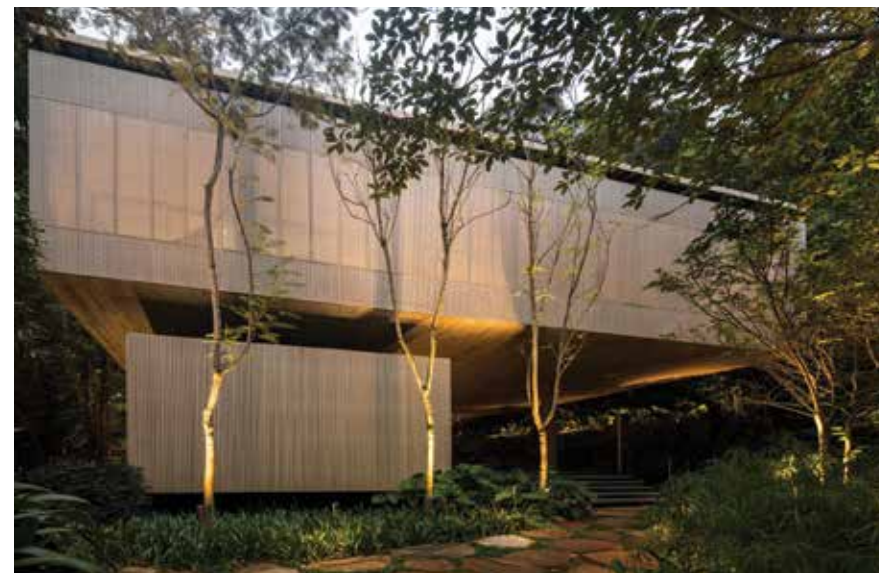
Casa na Mata, Guarujá. Projeto vencedor do Prêmio Obra do Ano 2017. Projeto: Studio MK27. Foto: Fernando Guerra.
