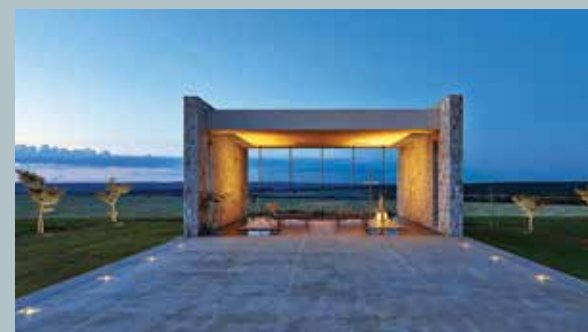
Capela na Fazenda Santa Helena, Bom Despacho (MG). Projeto do escritório vencedor do 12º Prêmio Arquiteto e Urbanista do Ano, categoria Setor Privado. Projeto: B&L Arquitetura. Foto: Jomar Bragança.
